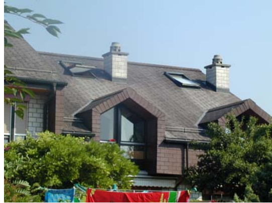
Tuiles en fibrociment, photo: JMF/SLE, IST
