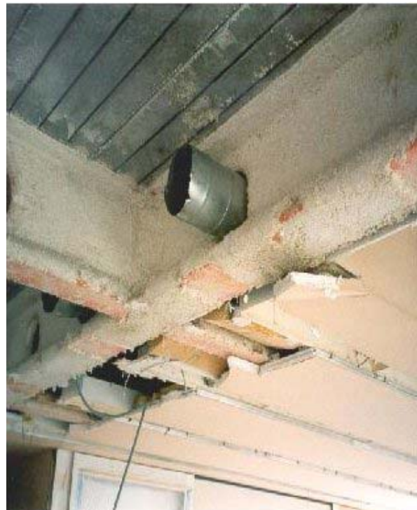
Flocage d'une structure métallique, photo: JMF/SLE, IST
