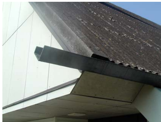
Toiture ondulée en fibrociment, photo: JMF/SLE, IST
